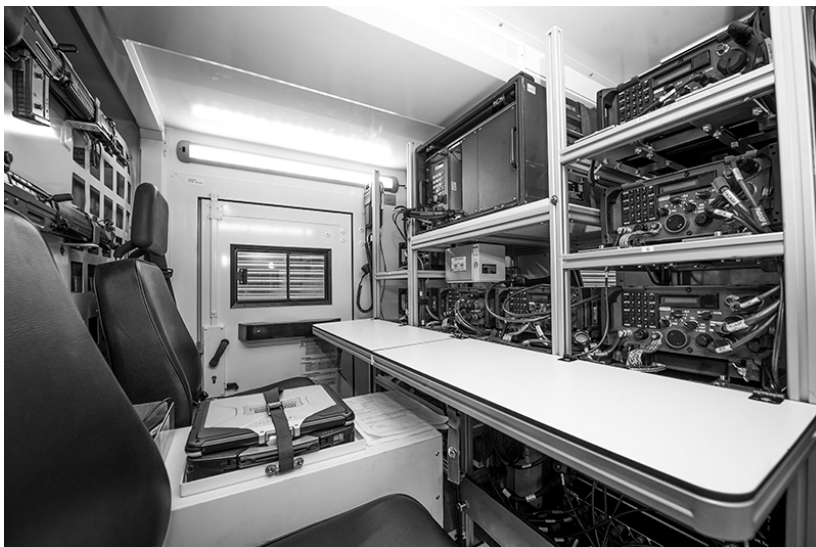
Vue de l'intérieur d'un véhicule pour systèmes techniques
